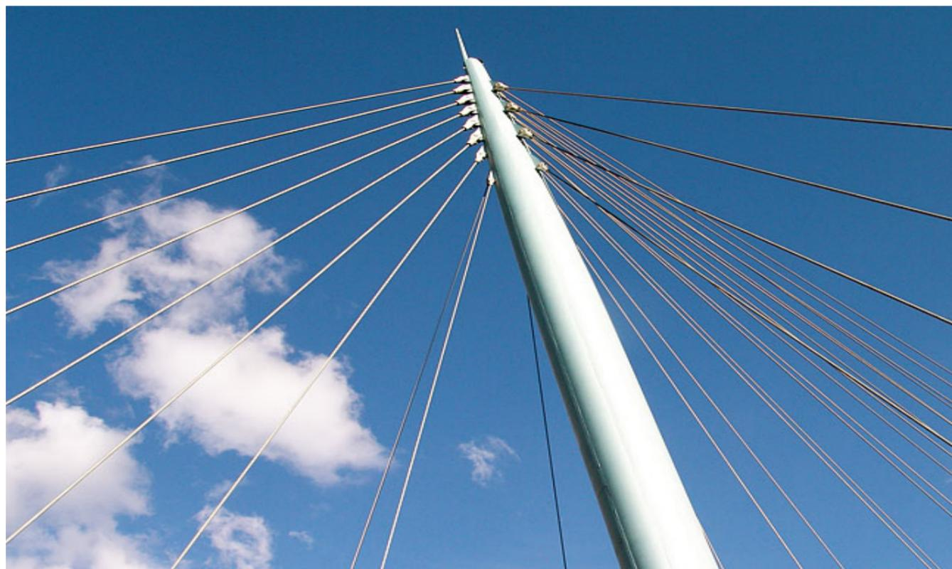
Sopra. Particolare di sommità dell'antenna e degli stralli. Ogni strallo è costituito da funi ad alta resistenza zincati a caldo. Le funi sono pre-tese con una forza di 1/3 del carico nominale di rottura prima del montaggio.
